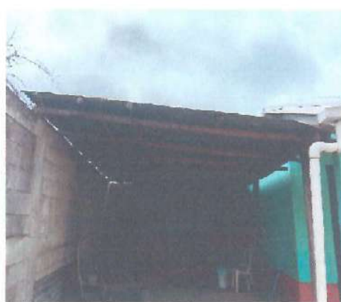
Foto 2: MEJORAMIENTO DE TECHO TIPO PORTICO E INSTALACIÓN DE LAMINA CALIBRE 26.
