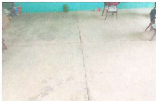
Foto 3: MEJORAMIENTO Y SUSTICIÓN DE PISO
