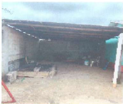
Foto 1: MEJORAMIENTO DE TECHO TIPO PORTICO E INSTALACIÓN DE LAMINA CALIBRE 26.
